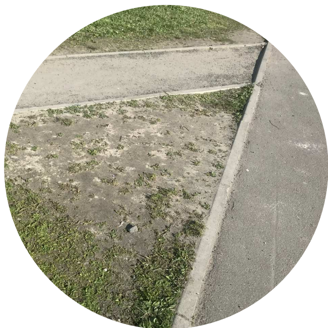
вытаптывание углов, открытый грунт, который создает пыль
